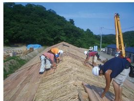
断熱材 屋根に敷き込まれた萱
