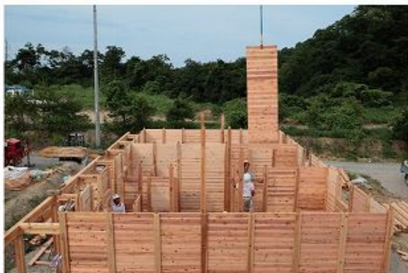
構造と化粧を兼ねる「落とし板パネル」
