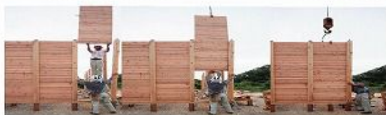
「落とし板パネル」を落とし込む状況
